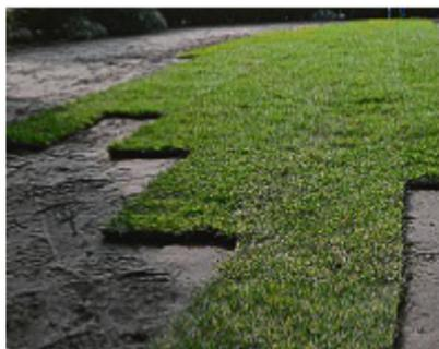
Bahn für Bahn wird der sattgrüne Rollrasen auf dem vorbereiteten Untergrund verlegt.
